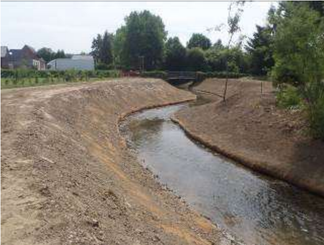
Secteur aval : profil vu de la salle
