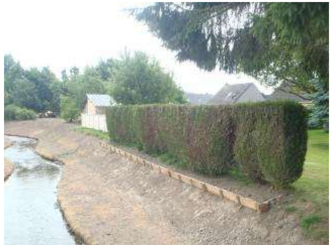
Tunage sous la haie.
