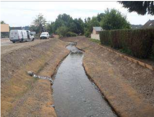
Secteur amont en cours de végétalisation.
