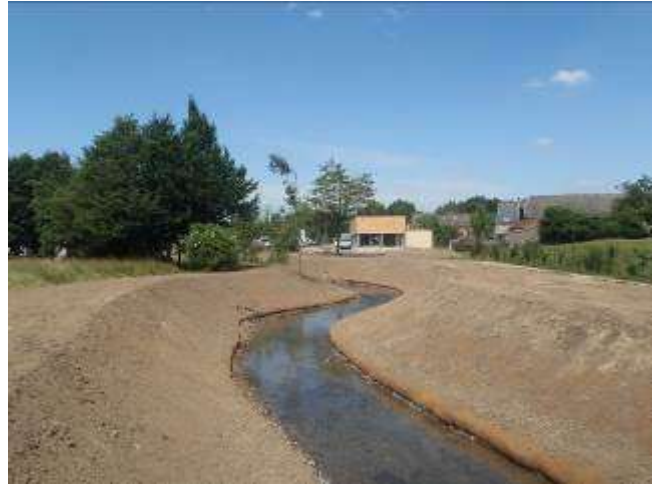
Secteur aval : profil vu du pont
