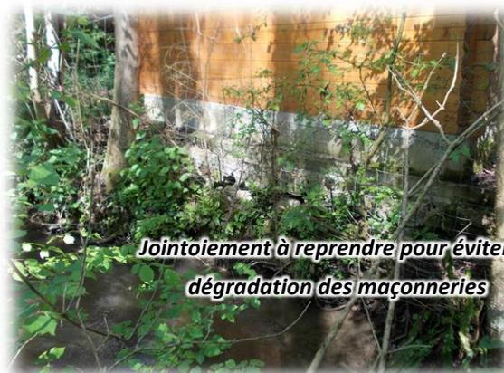
*Jointoiment à reprendre pour éviter la dégradation des maçonneries*
