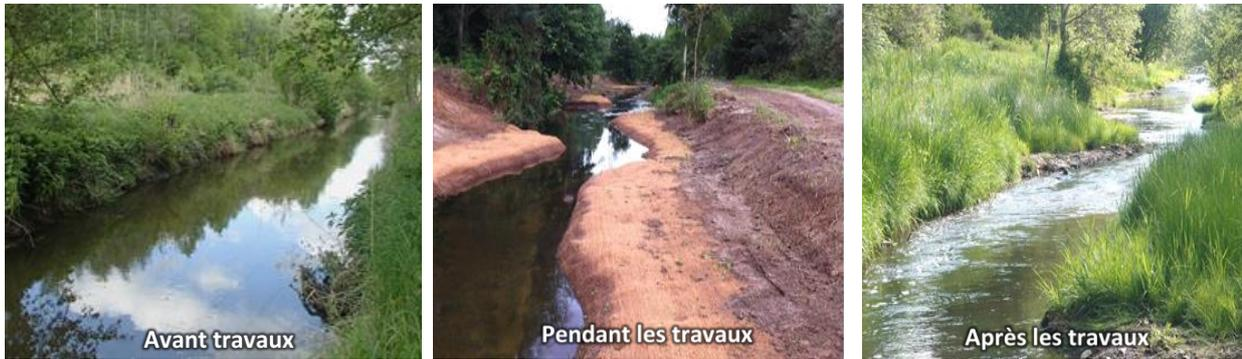
**Exemple : Travaux visant à favoriser la reconstitution d'un lit d'étiage sur la rivière Ardon réalisé en 2014 sous la maîtrise d'œuvre de l'USAGMA**
