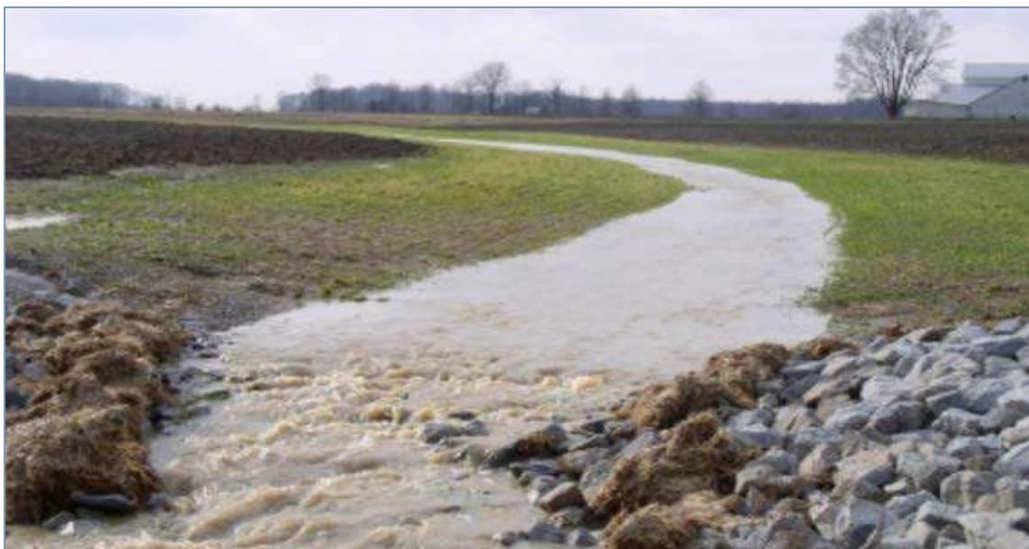
Figure 26 : noue enherbée de décharge en situation de fonctionnement
