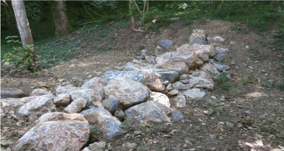
Figure 15: exemple de seuil en enrochement libres implanté dans un ravin
