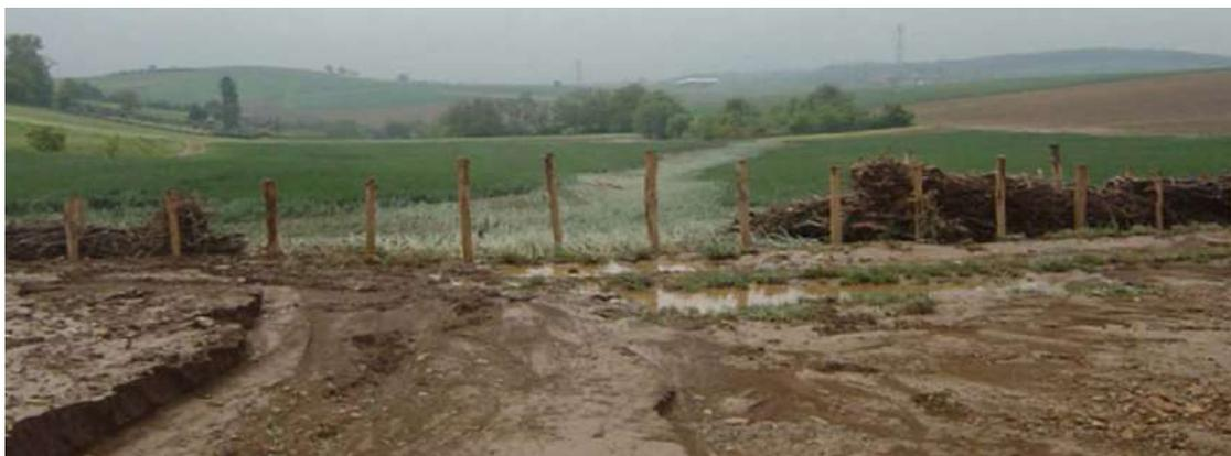
Photo 8 : rupture de fascine par pression hydraulique d'un ruissellement concentré à fort débit
