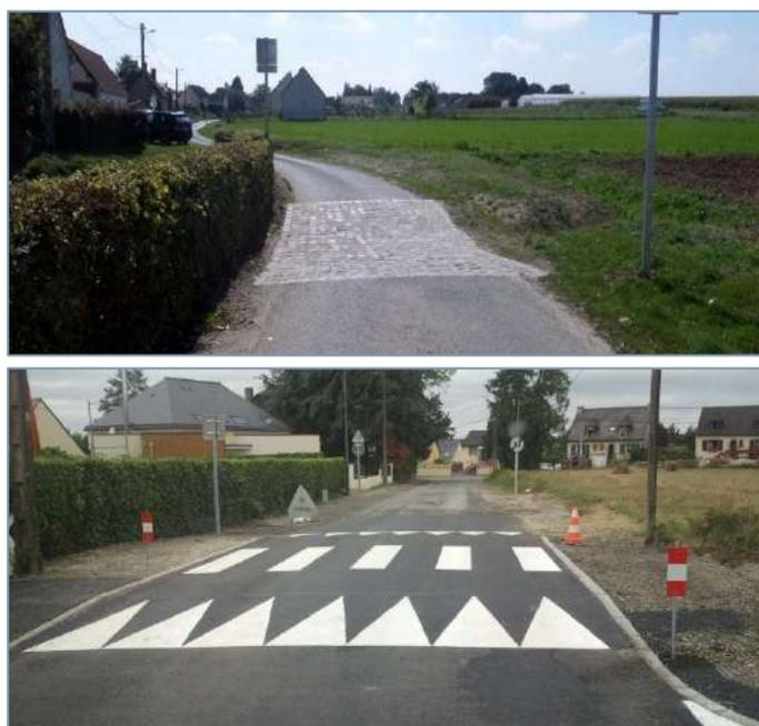
Figure 11 : exemples de dispositifs de déviation des eaux par réaménagement de la voirie
