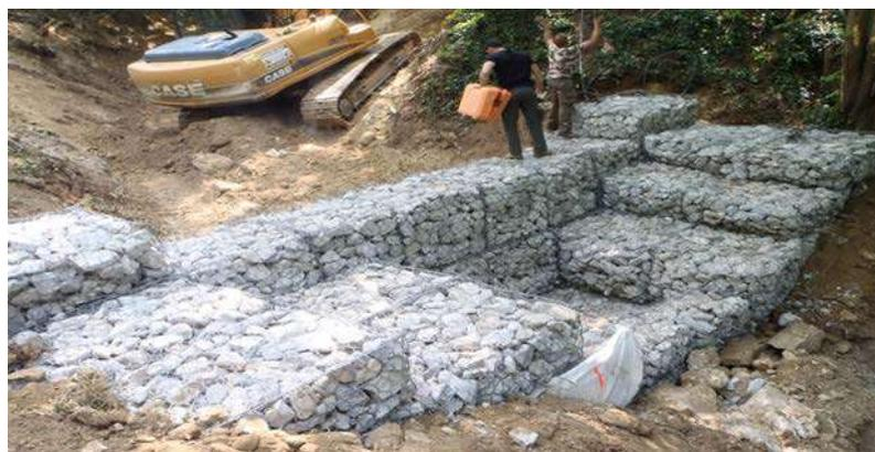
Figure 14 : exemple de structure gabion avec dissipateur aval
