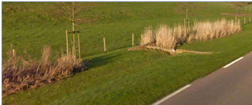
Figure 13 : exemple de redent mise en place au sein d'une noue enherbée
