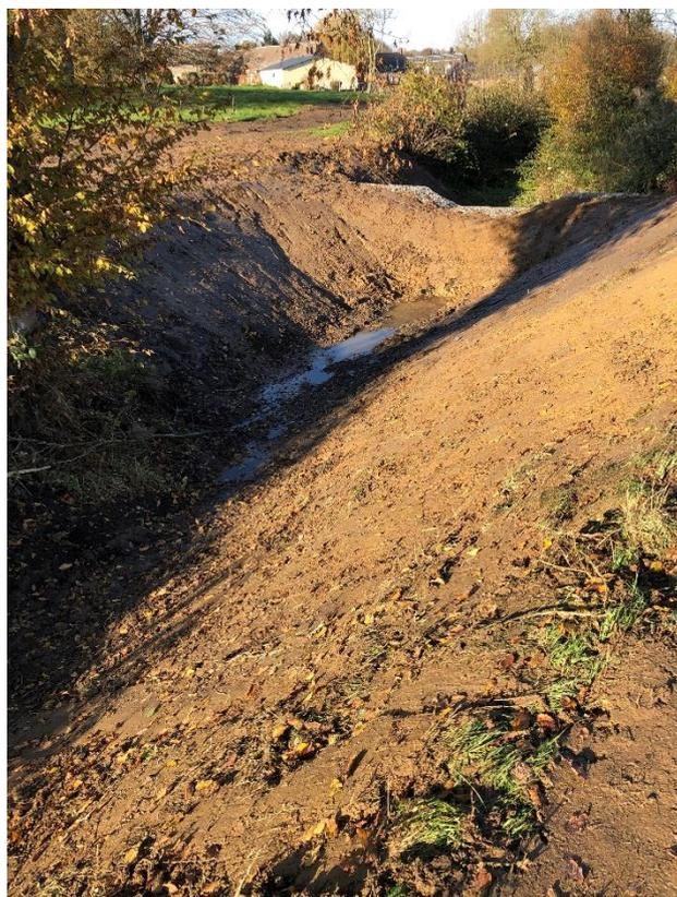
Figure 2. Pentes retalutées par l'entreprise en amont du gabion n°3 (amont)
