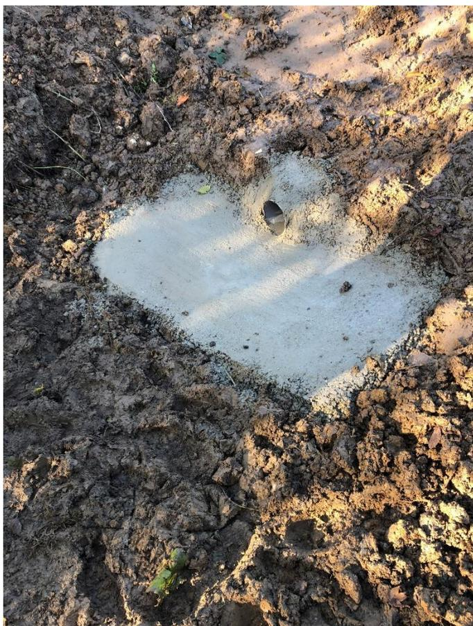
**Figure 5. Plateforme béton à l'entrée de la canalisation du gabion n°2**
