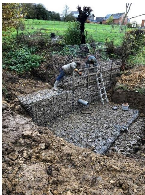
**Figure 9. Remplissage du gabion n°1 (aval)**
