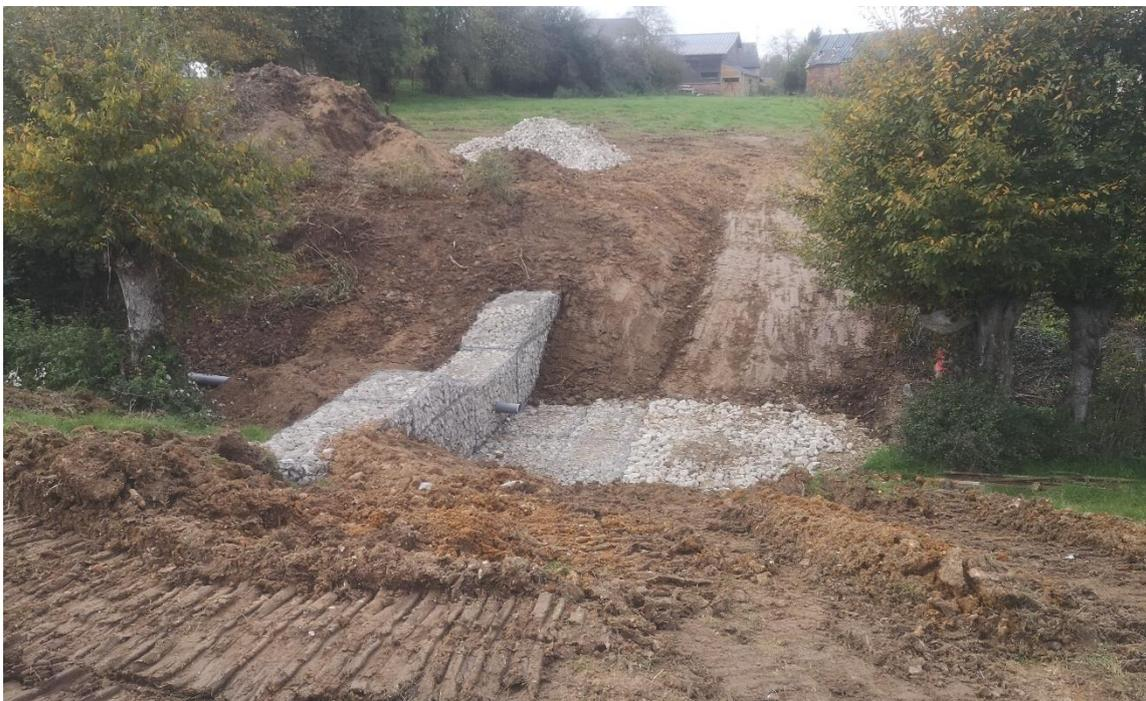
**Figure 4. Gabion n°2 (médian) et le passage à gué (sans enrochement)**
