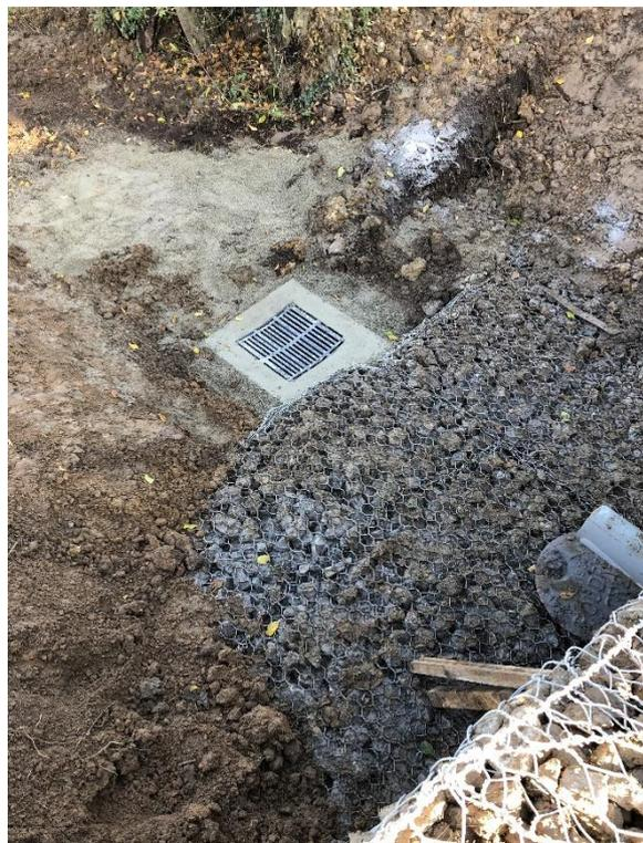
**Figure 11. Grille de protection de tête de drain (aval)**
