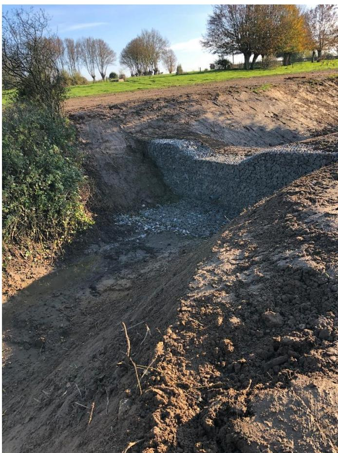
**Figure 1. Gabion n°3 (amont)**
