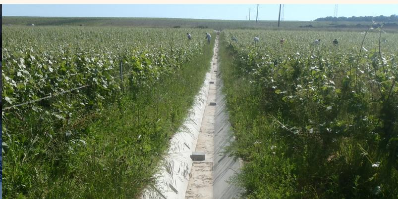
Caniveaux bétons trapézoïdaux à rédents
