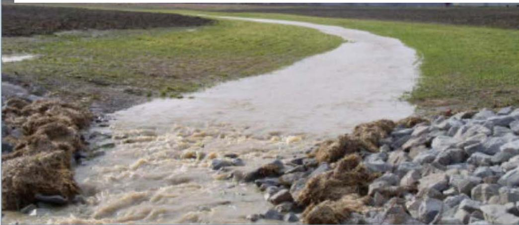
Figure 26 : noue enherbée de décharge en situation de fonctionnement
