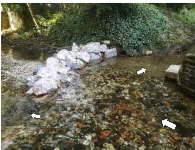
Epi mis en place – vues amont et aval
