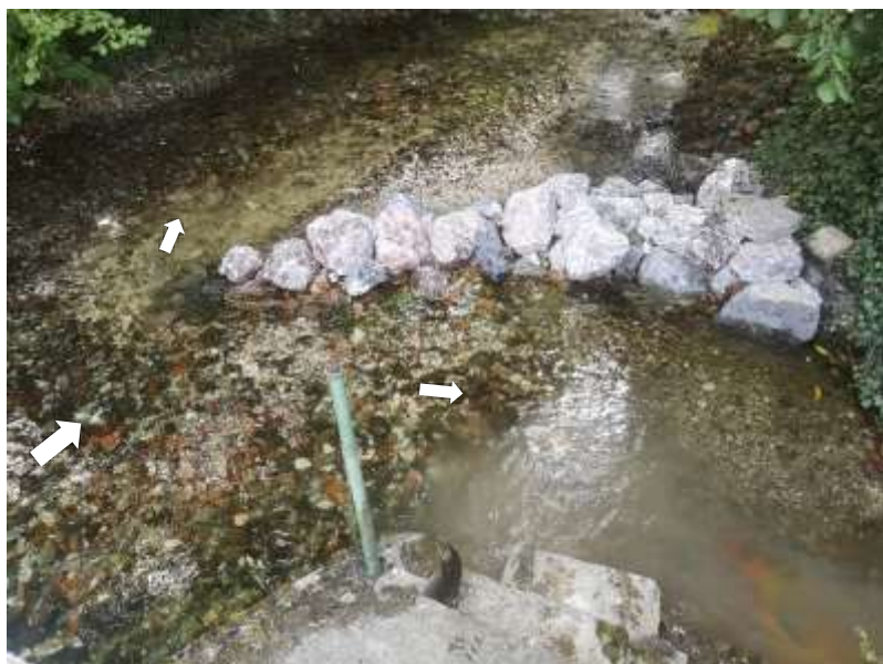
Epi mis en place – vues du dessus et entrée d'eau dans le ru de Moy
