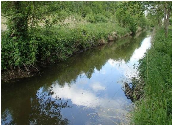
Cours d'eau (l'Ardon) rectifié et recalibré aux écoulements lents et homogènes
