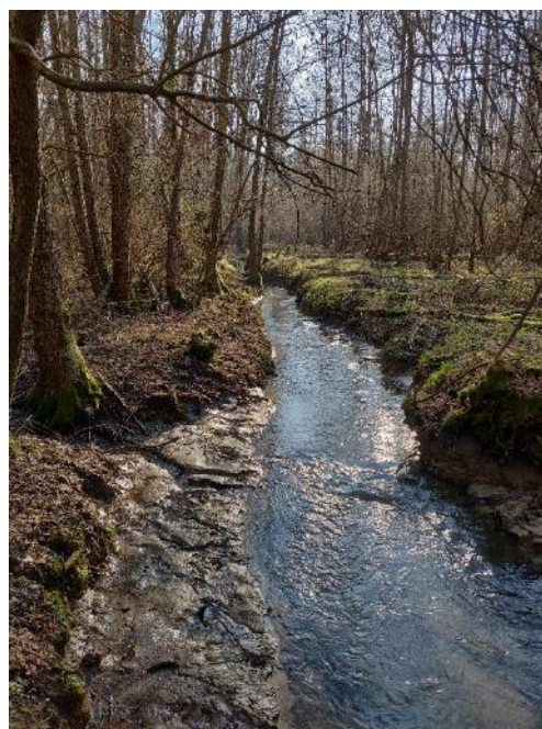
Photo après travaux (Tronçon 8.VIS.2)
