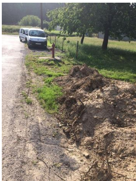
Vue sur le nettoyage du chantier à réaliser côté exutoire de la prairie. Ramassage de la terre en trop et du restant de béton et grave
