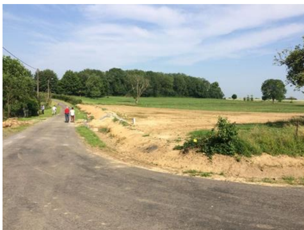
Vue sur la prairie inondable terminée hors travaux du lot 2
