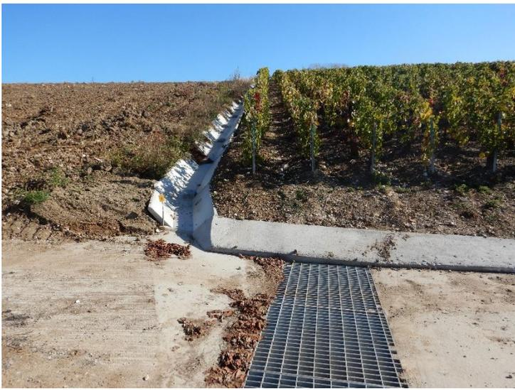
Caniveau béton à redents succédé par un dépierreur et un chemin béton
