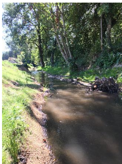
Ancrage de souches d'arbres sur les banquettes
