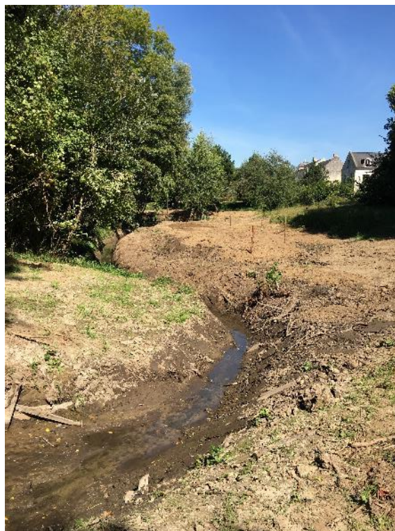
Fossé d'alimentation de l'étang après travaux
