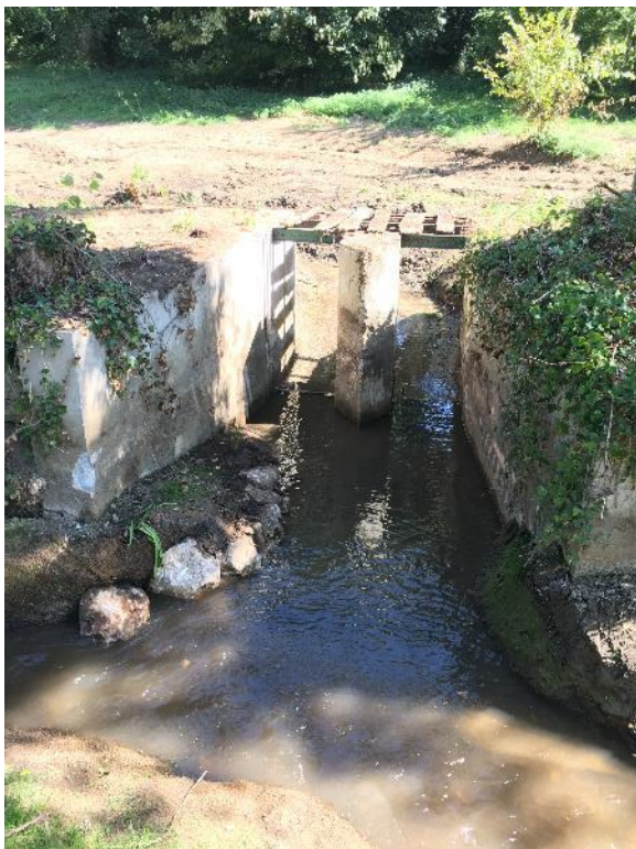
Prise d'eau de l'étang après travaux
