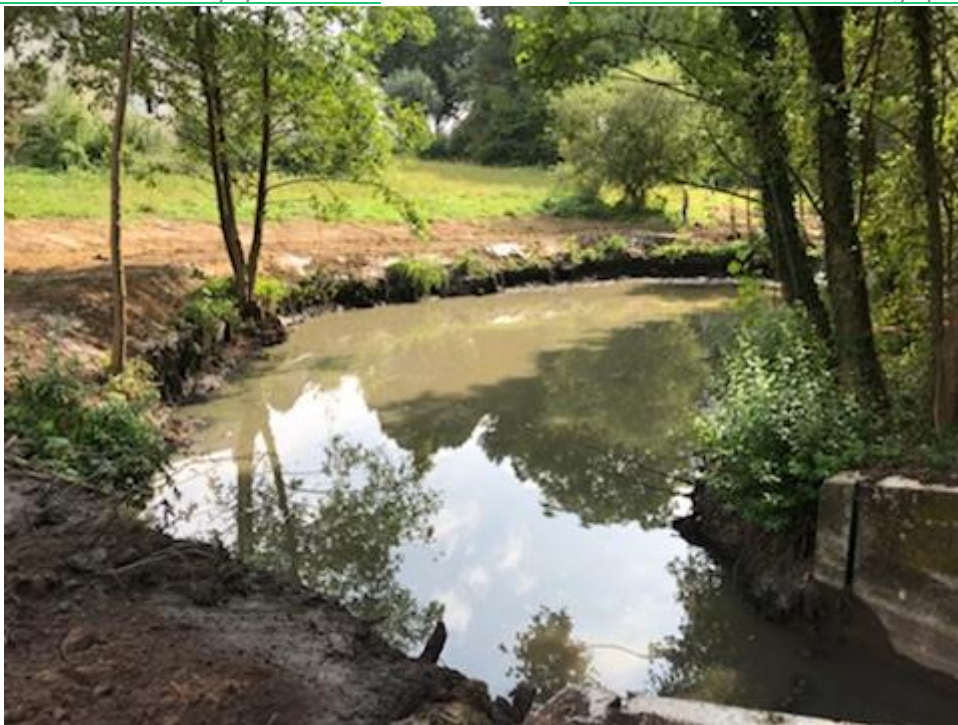
Etang après travaux
