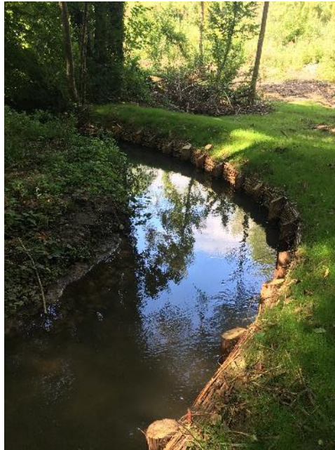
Renforcement de la berge en amont du projet
