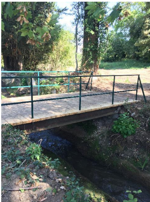
Remise en état de la passerelle
