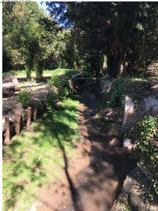
Aval de la passerelle, après travaux
