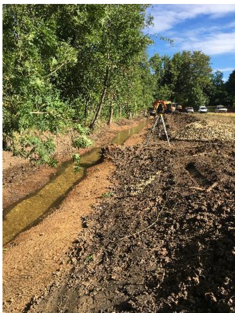
Création de banquettes et mise en place d'un géotextile en fibre de coco
