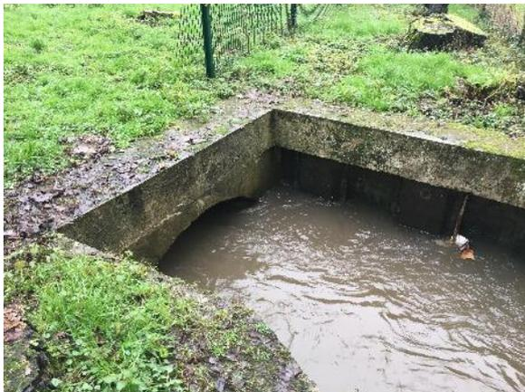
[Buse de 11 ml, diamètre 1000 mm avec renforcement béton](#)
