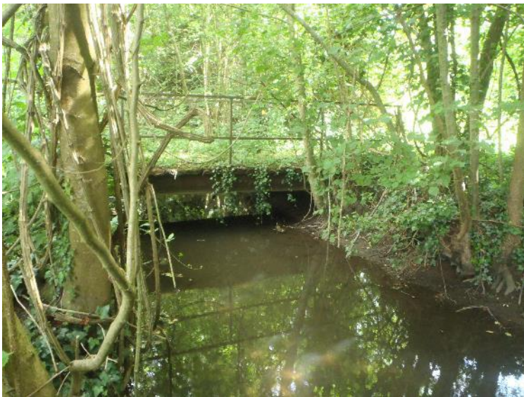
Passerelle avant travaux
