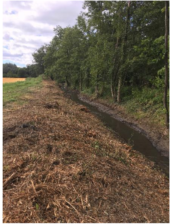
Entretien de la berge en rive droite du ru de Retz
