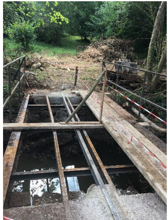
Remise en état de la passerelle en cours de réalisation
