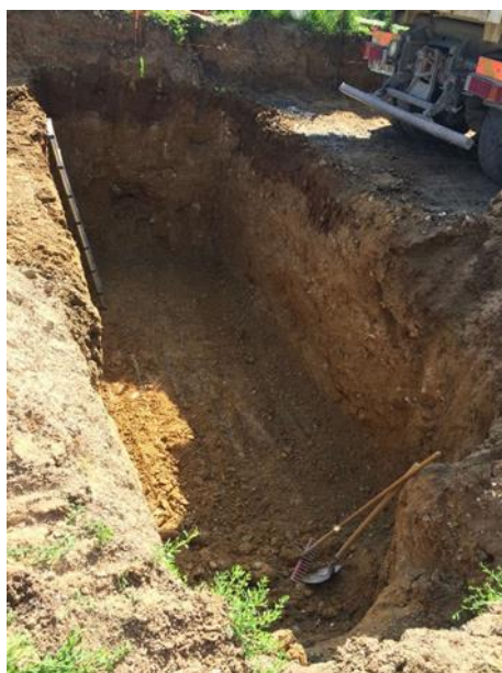
Vue sur la pose du dégrilleur n°219
