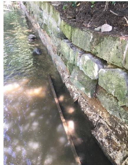
Erosion de l'assise du muret en rive droite
