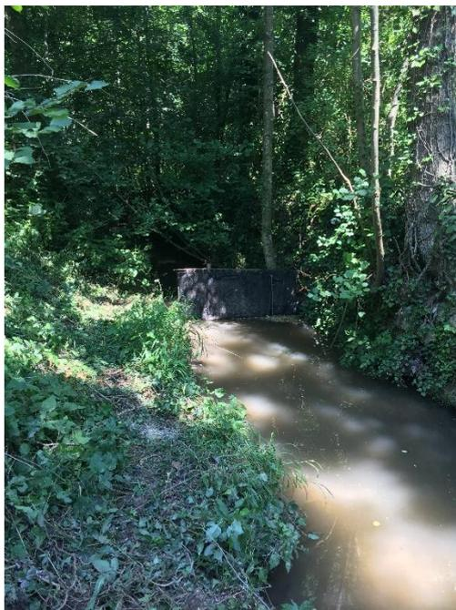
Mise en place d'un filtre à sédiment en aval
