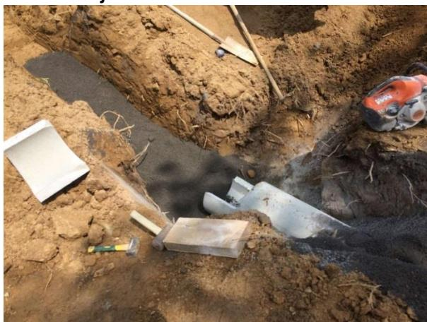
Les travaux sont en cours pour la pose des canalisations sous les entrées de champs, il reste les têtes de sécurité à poser
