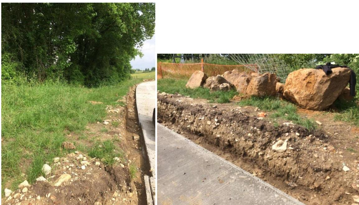
La réalisation des accotements dans les zones hors déblais sera réalisée avec le mélange terre/pierre ramassé après les coulées des orages d'août 2017, stockées sur la plateforme Moët.
