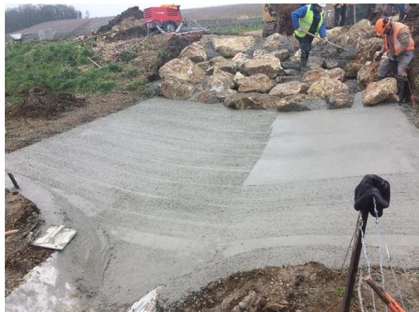
Vues sur le 172 terminé – Reste à décoffrer et les finitions au droit des raccordements chemins/espaces verts/dalle béton
