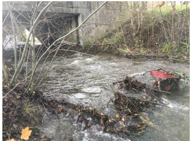
Création de micro-seuil en aval du radier du pont
