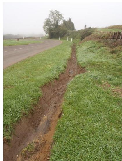
Il est proposé la réalisation des redents par la mise en place de matériaux de granulométrie 80/150 percolés au mortier d'une hauteur maximale de 30 cm. **RVM doit transmettre une coupe type pour transmission au CD 02.**
