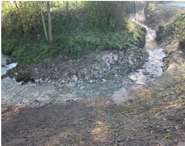
Suppression de la dernière marche du seuil
