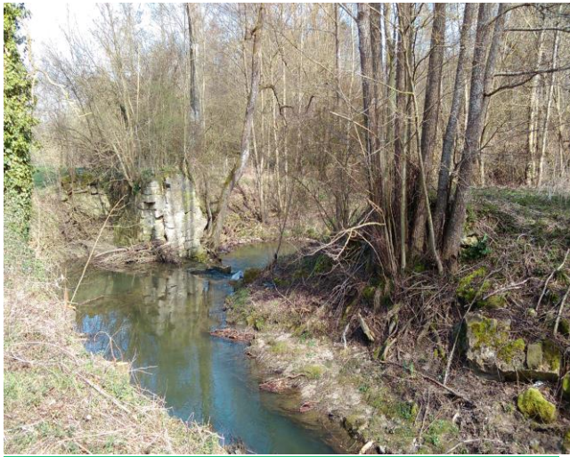
Vue amont du site avant travaux
