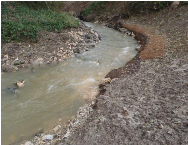
Mise en place du géotextile dans la partie concave du méandre
