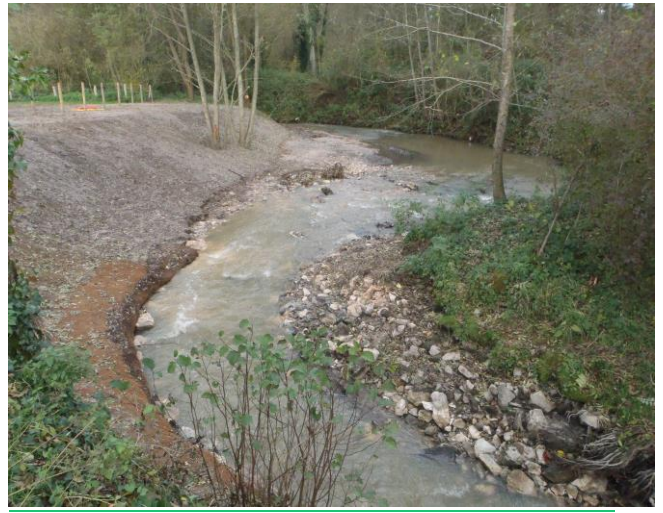
Vue amont du site après travaux
