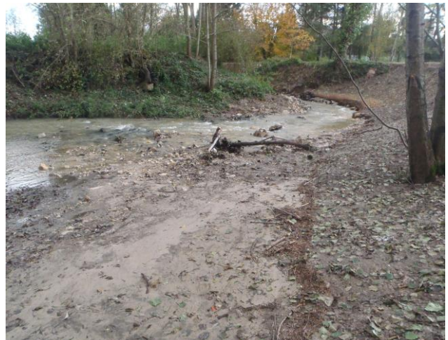
Banquette rive gauche finalisée
