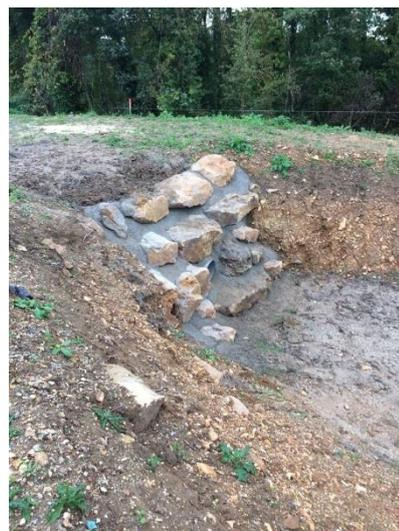
Reste à faire la cunette en béton pour la liaison entre le dépierreur et les enrochements percolés ainsi que la réalisation d'une finition autour des canalisations en enrochements bétonnés.
