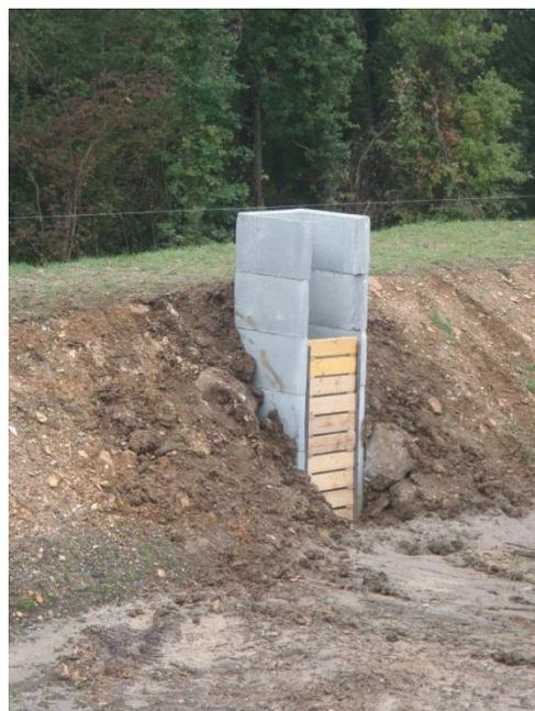
Les enrochements ont été percolés au béton et l'ouvrage de régulation posé.
