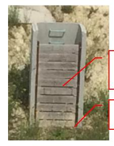
Ouverture de 4 cm au lieu de 3 cm pour passage de l'eau et blocage des flottants
