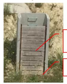
Ouverture de 4 cm au lieu de 3 cm pour passage de l'eau et blocage des flottants
