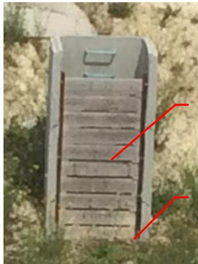
Ouverture de 4 cm au lieu de 3 cm pour passage de l'eau et blocage des flottants
