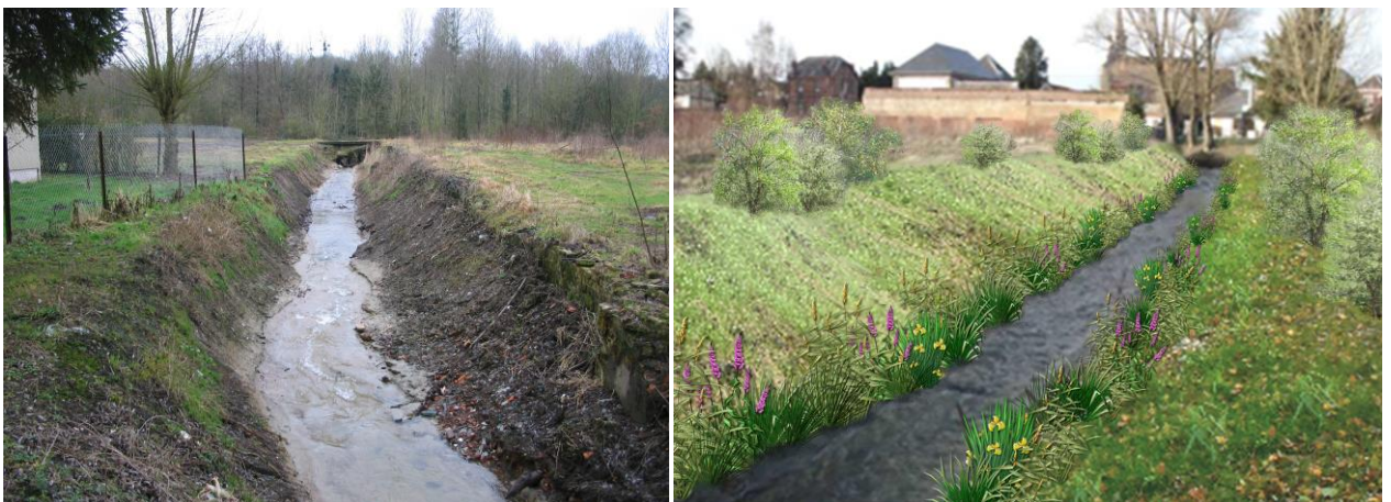
Projection des travaux de restauration de berges en aval de Boué
