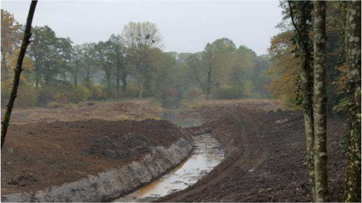
Détail bouchon amont de la nouvelle dérivation
