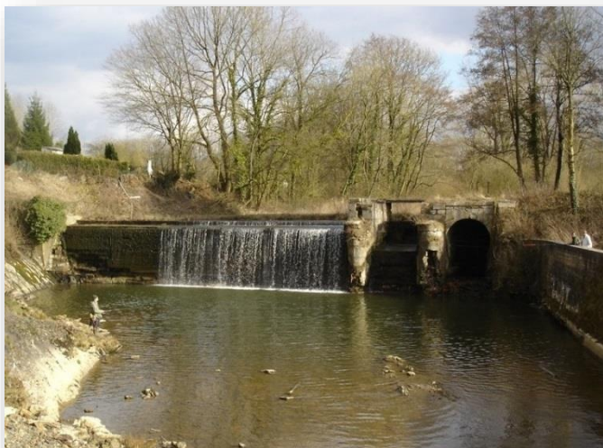
Seuil de Sougland (avant les travaux)
