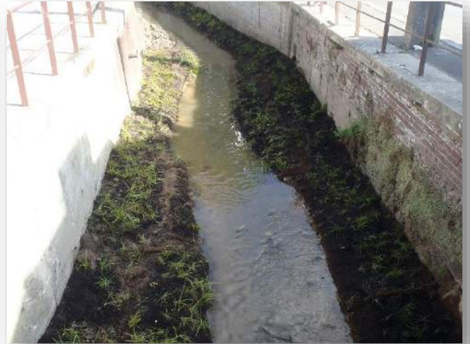
Mise en place d'un géotextile végétalisé (pendant les travaux)
