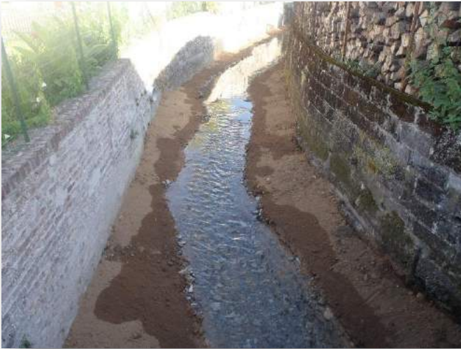
Création d'un lit sinueux par la mise en place de banquettes (pendant les travaux)
