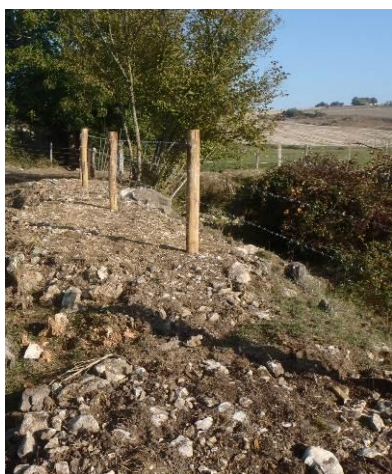
Suppression des merlons de curage pour la pose de la clôture
