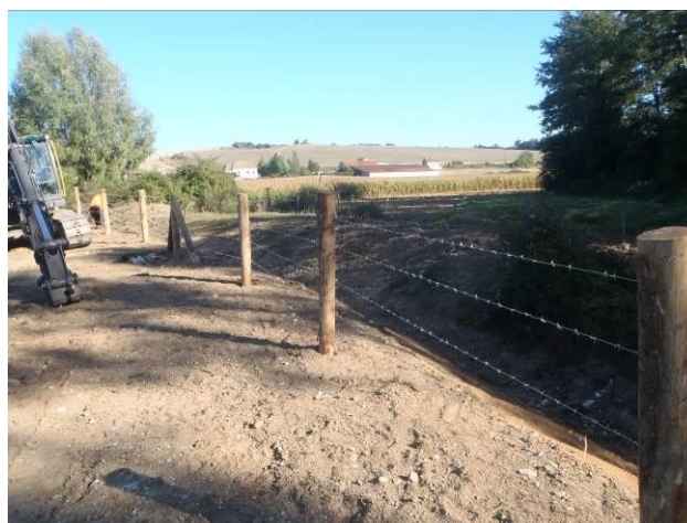
Pose de la clôture
