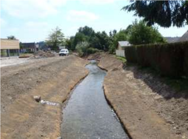
Secteur amont : profil vu du pont
