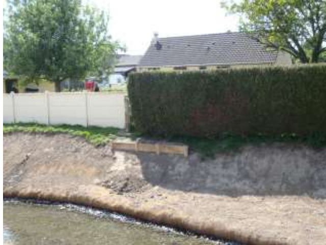
Tunage à réaliser le long de la haie
