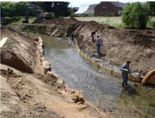
Secteur aval : talutage et conception des banquettes.
