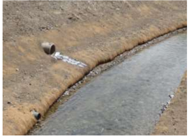
Rigole empierrée à l'exutoire de réseau
