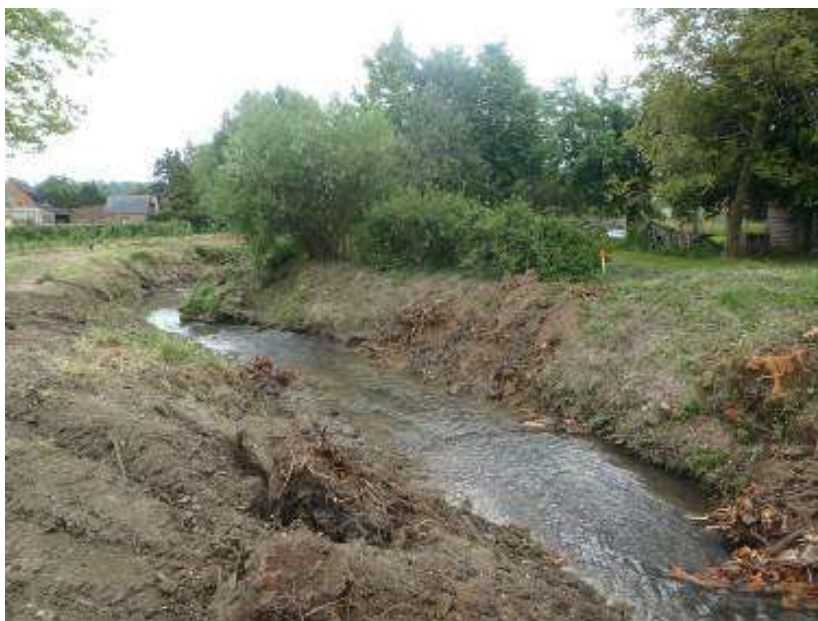
Nettoyage des emprises et dessouchage en cours
