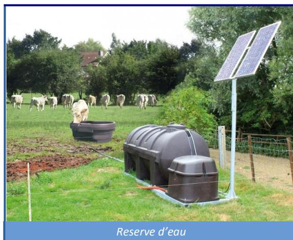
La pompe immergée d'un  $\varnothing$  100 mm ( $\varnothing$  mini du puit = 120 mm) est capable de pomper de 0 à 50 mètres avec un débit de 160 à 360 litres/heure. 2 panneau solaire 80 Wc avec mât : - solides et fiables (composants électroniques et structure de marque) - montage et entretien facile.
