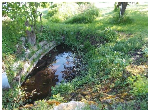
La retenue en amont de l'ouvrage est végétalisée avec un risque de colmatage. L'aval de l'ouvrage crée une petite chute. La restructuration de l'ouvrage permettrait de le rendre franchissable.
