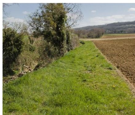
Exemple de noue d'infiltration
