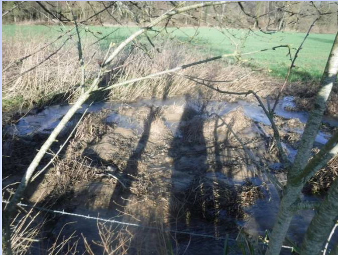
Importants dépôts de limons dans le ru de Launoy
