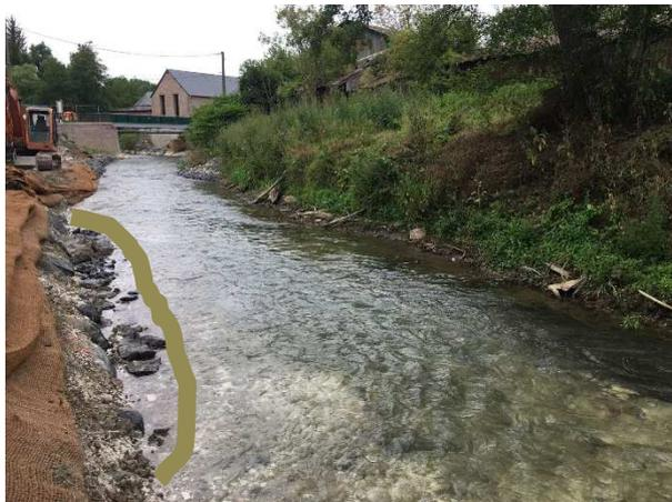
Il est acté de faire une banquette granulaire en rive gauche à 20 en amont de celle faite en rive droite et de continuer la banquette granulaire (40/60 des bigbags) en rive droite comme sur le croquis ci-dessous
