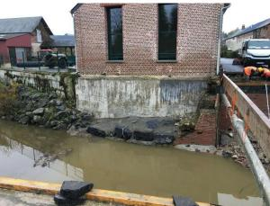
La commune est en cours de travaux dans l'ancienne prise d'eau du moulin pour canaliser son réseau EP. CGCR démarrera la fermeture de la galerie dès la fin de la pose de la canalisation.
