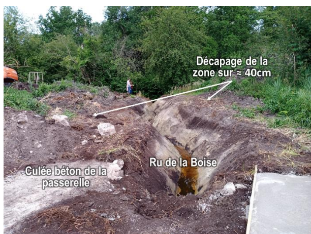
Décapage des berges du ru de la Boise
