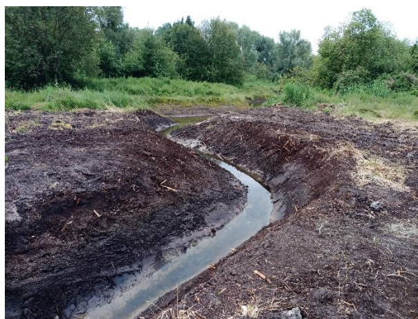
Connexion du ru de la Boise à l'Ardon
