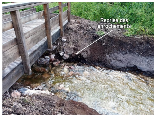
Enrochements à reprendre
