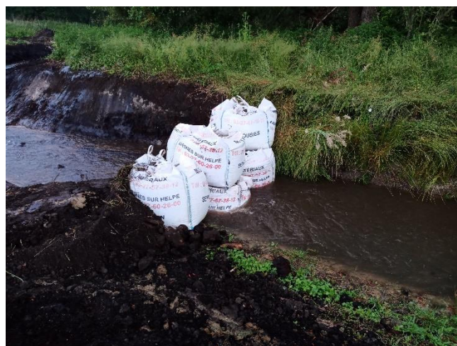
Mise en place de 6 big-bag sur le nouveau bras
