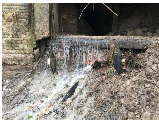
Le marché comprend uniquement le comblement de l'ouverture par la réalisation d'un mur et la pose d'un clapet anti-retour en diamètre 600 mm. A charge de la commune d'entretenir son ouvrage pluvial.
