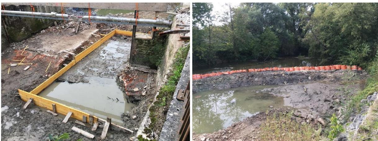
Le bétonnage de la demi-section du nouveau seuil a été réalisé le 15 octobre.
