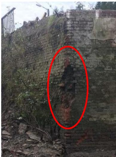
A l'issue de la pose de la nouvelle passerelle et de la reprise des supports de la canalisation EU, le massif en maçonnerie sera reprofilé selon les redents faits contre le mur de la mairie en suivant la fissure existante.
