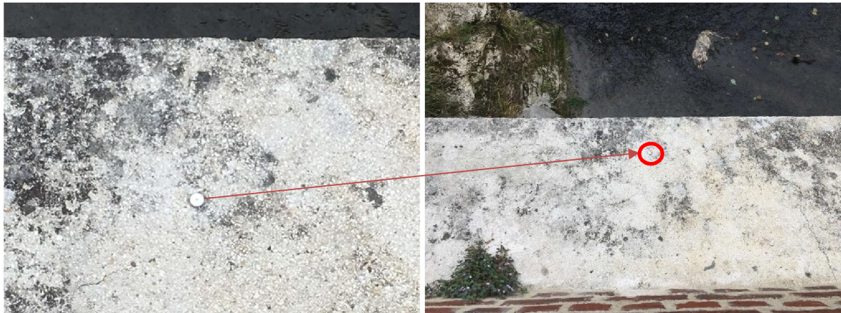
Repère de nivellement posé sur le mur en béton présent) l'aplomb du pignon de la mairie (côté Serre)
