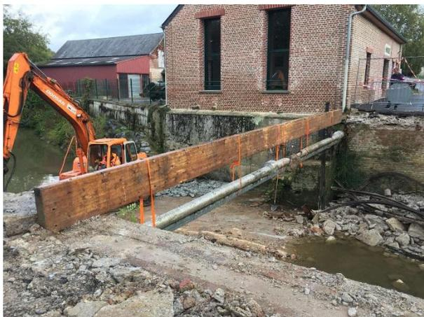
Il est noté qu'au droit de son ancien passage dans la pile, le calorifugeage a été découpé et que seule la canalisation en fonte était insérée dans la tête de pile.
