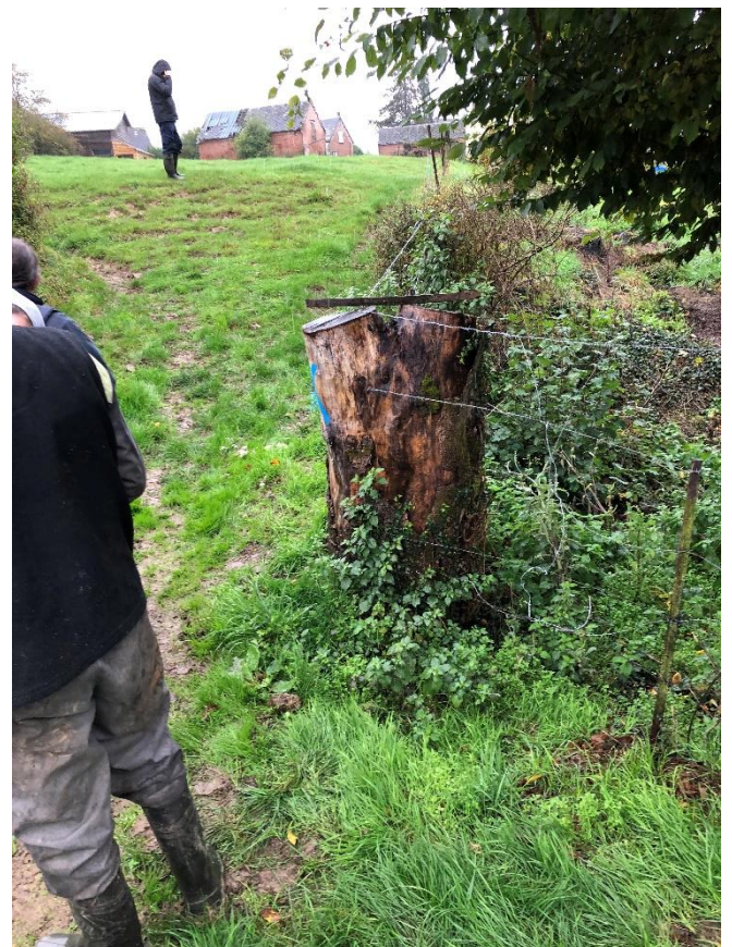
Figure 6. Souches à enlever pour la mise en place du gabion n°2 (médian)
