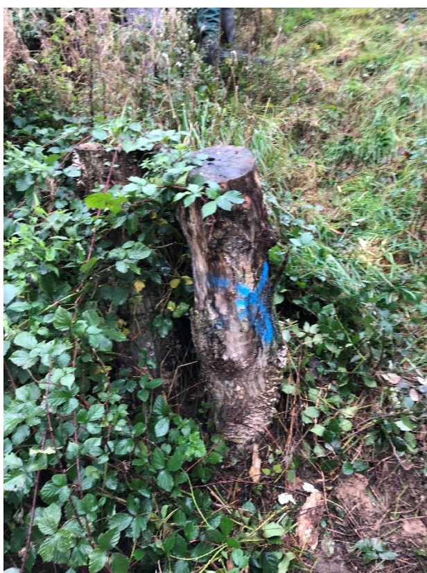
Figure 4. Souches à enlever pour la mise en place du gabion n°3 (amont)
