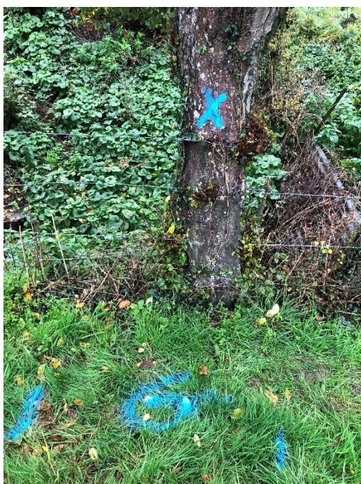
Figure 8. Souches et arbres à enlever pour la mise en place du gabion n°3 (aval)
