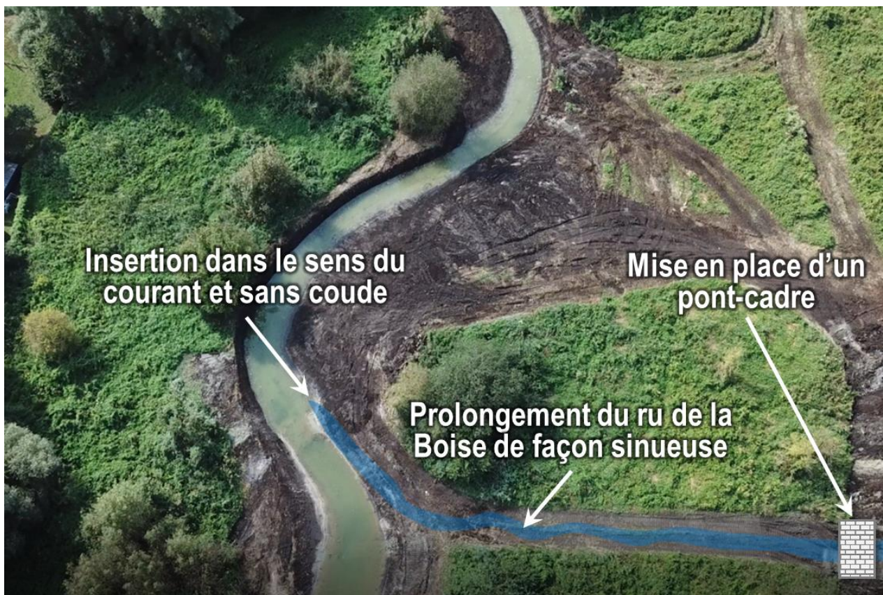
Connexion du ru de la Boise au nouveau tracé de l'Ardon
