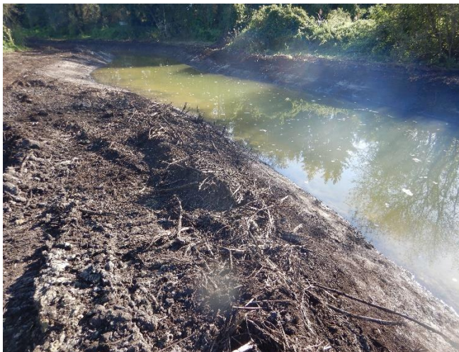
Talus à reprendre (présence importante de rémanents)
