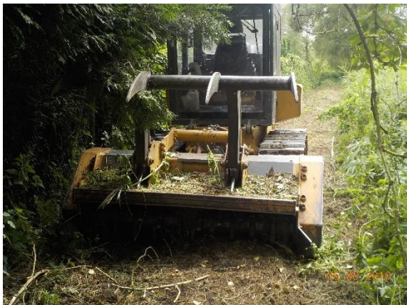
Débroussaillage du site au droit du futur tracer de l'Ardon
