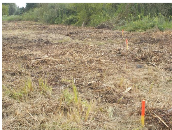
Jalons de piquetage (haut de berge rive gauche) et arbres à conserver
