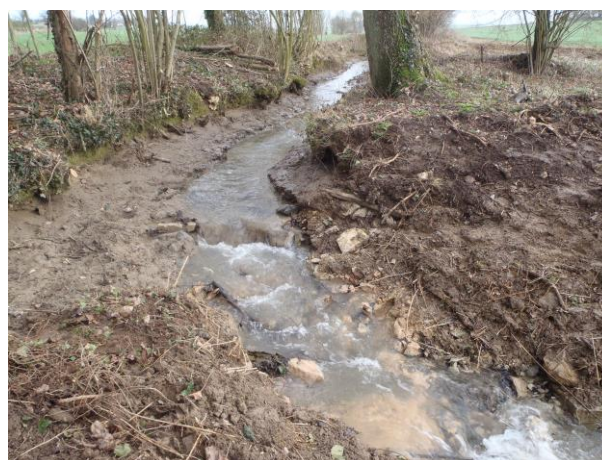
Formation de banquettes suite à l'arasement de l'ancien seuil Succession de micro-chutes permettant le rétablissement de la continuité piscicole et sédimentaire
