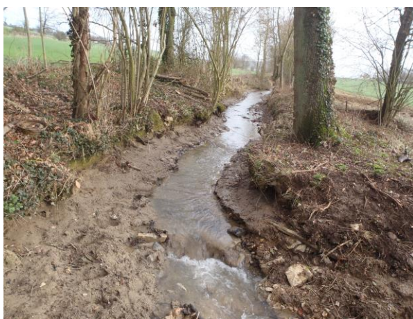
Formation de banquettes suite à l'arasement de l'ancien seuil Succession de micro-chutes permettant le rétablissement de la continuité piscicole et sédimentaire
