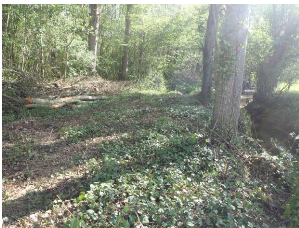
Remise en état de la piste d'accès
